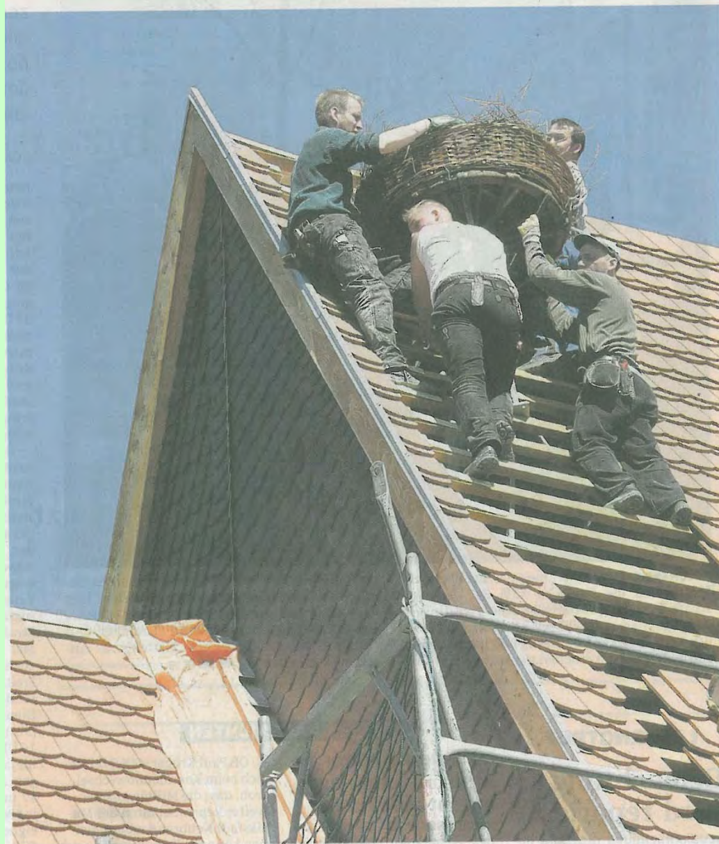
Mitarbeiter der Neuhaus Bauunternehmen GmbH Neustrelitz bei der Montage des Horstes auf dem Dach der Kirche in Neddemin.
