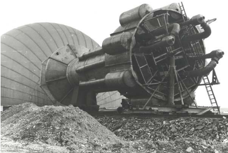
Abbildung 1: Tiefenwasserbelüfter Typ Schönbrunn auf der Slipanlage vor der Montagehalle am Ufer der Bleilochsperre. Foto: Klapper
