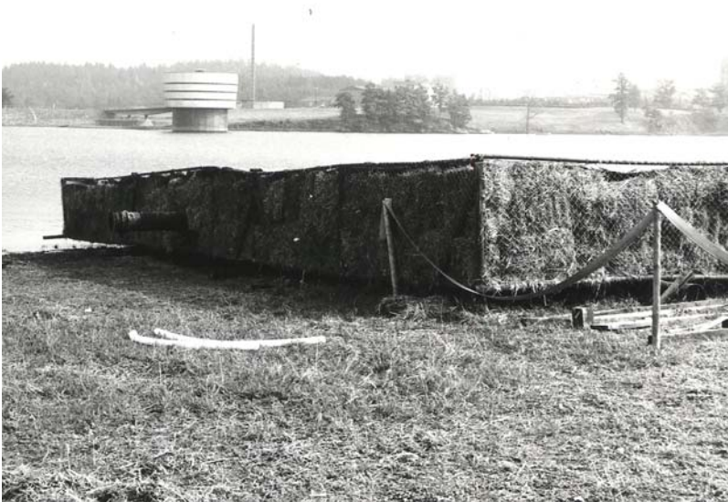
Abbildung 3: Heterotrophe Nitratelimination im Hypolimnion einer Trinkwassertalsperre. Das Strohsinkstück liegt kurz vor dem Einschwimmen noch am Ufer. Über das Rohr (links) und ein Verteilssystem wird das nitratreiche und mit einer C-Quelle angereicherte Wasser durch den Aufwuchsreaktor gedrückt. Foto: Klapper
