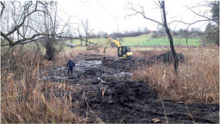
Abb. 3: Beginn der Teichentschlammung mittels Bagger
