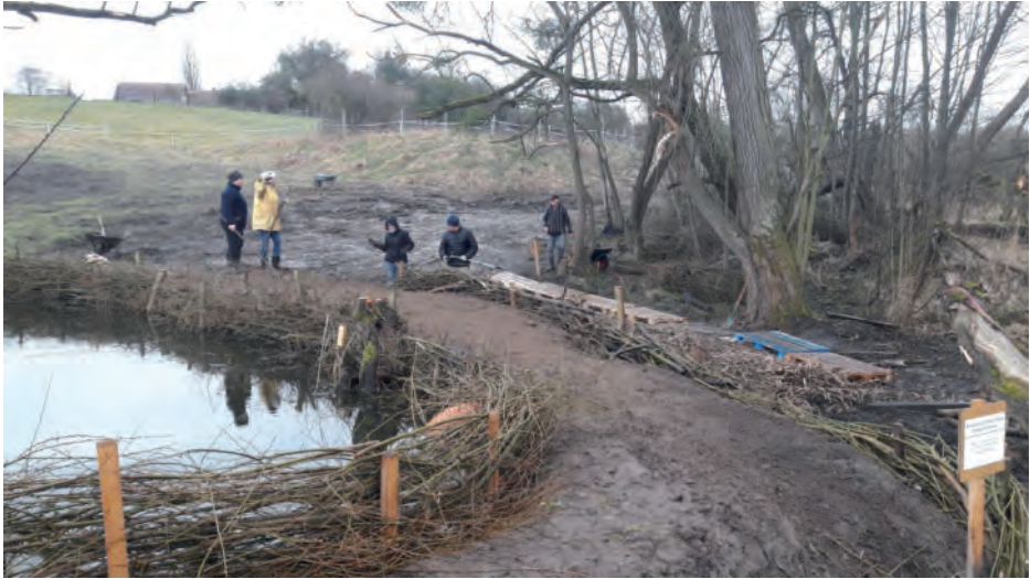
Abb. 5: Bau der Stauschwelle durch Vereinsmitglieder
