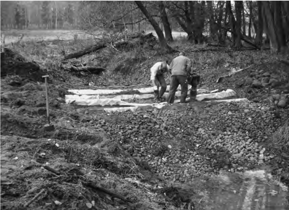
Abbildung 3: Bau von 9 Sohlschwellen im Godendorfer Mühlenbach
