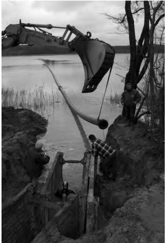
Abbildung 4: Verlegung der Tiefenwasserableitung im Dabelowsee
