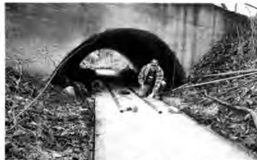
Der Betonsockel war zu Wochenbeginn fertig. Klaus-Dieter Seemer arbeitete an der Führung für die Rohre.
