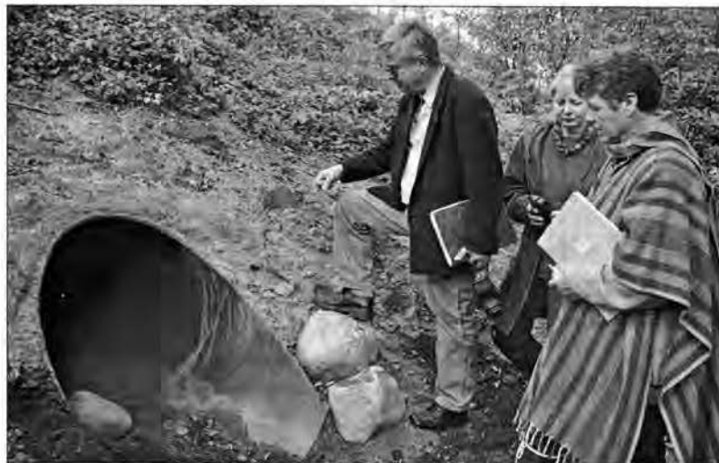
Der so genannte Fischotterpass führt 62 Meter unter der B 96 am Nonnenbach hindurch.
