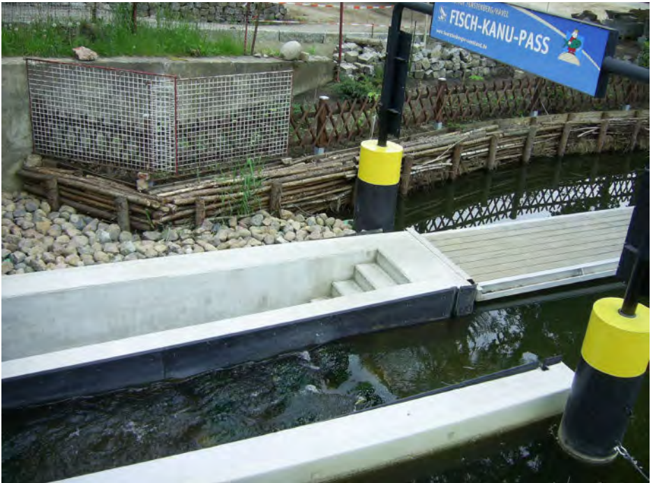
Im unteren Teil des Bildes ist der abwärts geneigte Kanal zu sehen, der mit Plasteborsten ausgelegt ist, um Beschädigungen an den Booten zu verhindern. Daneben befindet sich ein Gang für den Wasserwanderer, der sein Boot aufwärts ziehen kann. (Foto: H. Hemke)
