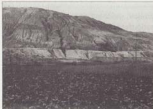
Hochhalde Espenhain (Kreis Borna), Juni 1950: unbeherrschte Böschungen der Halde werden durch die ungehindert abfließenden Oberflächenwässer in tiefen Rinnen aufgerissen, sterile Mineralböden mit eingelagerten kulturfeindlichen Substanzen lagern sich auf den umgebenden Äckern ab
