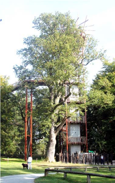
Abb. 5: Gesamtlänge: 620 m, Rampenlänge: 230 m, verbaute Stahlmenge: 230 Tonnen ...
