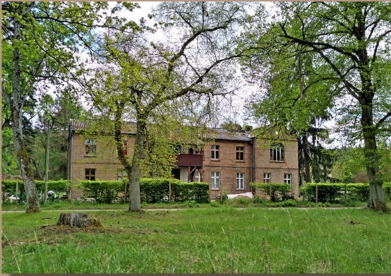
Das ehemalige Guts- und Forsthaus in Langhagen 2021
