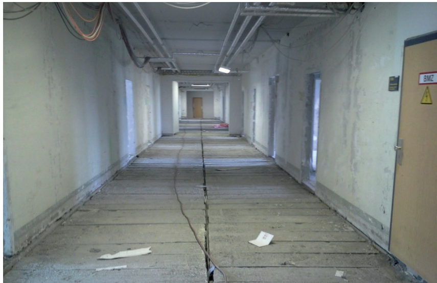
Erdgeschoss LG 1: Ansicht des Flures im Rohbauzustand
