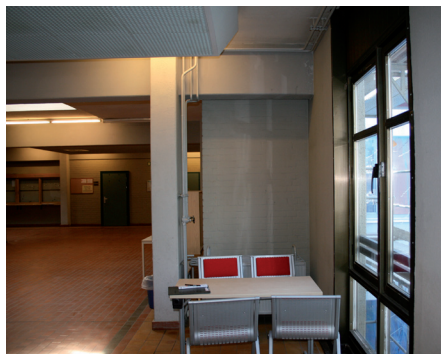
Das Foyer im Haus 1 vor der Sanierung.
