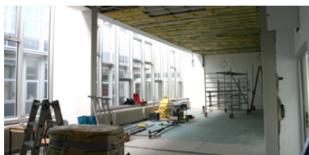
Umbaumaßnahmen im Laborgebäude von Haus 2, ehemaliges Bauphysik-Labor (Raum 046/047)
